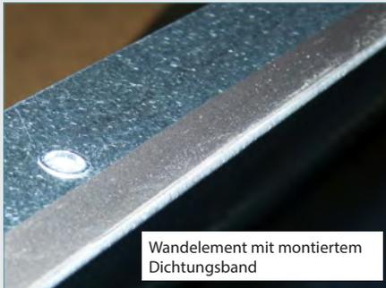
Wandelement mit montiertem Dichtungsband
